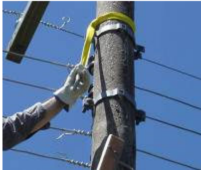
Figura 16 – Ancoragem com fita e mosquetão no poste
