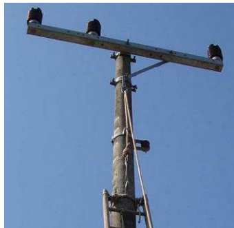
Figura 17 – Ancoragem na ferragem do poste
