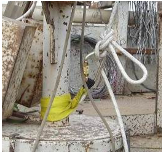
Figura 11 – Ponto de ancoragem
