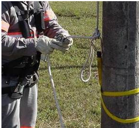
Figura 39 – Instalação do trava-quedas
