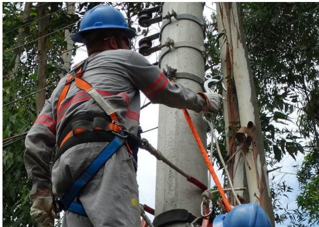
Figura 48 – Fixação do ponto de ancoragem
