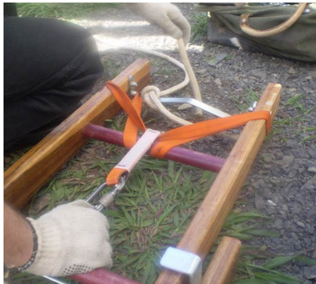
Figura 12 – Instalação do ponto de ancoragem
