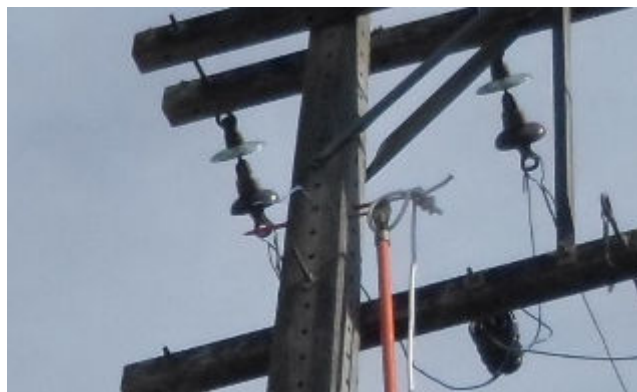
Figura 31 – Instalação do agulhão no poste
